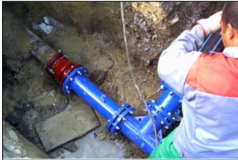
La jonction entre l'ancienne et la nouvelle canalisation.
