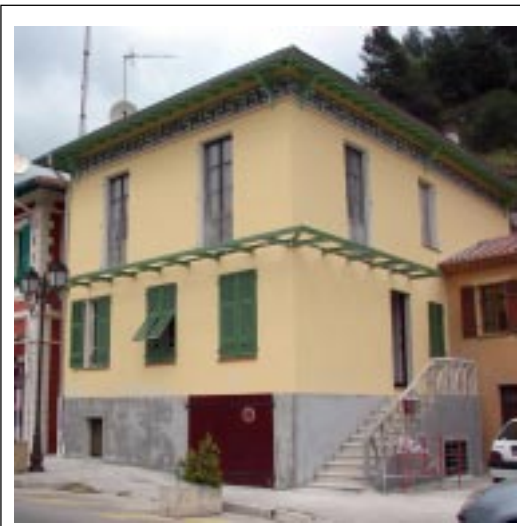
Exemple de façade rénovée.
