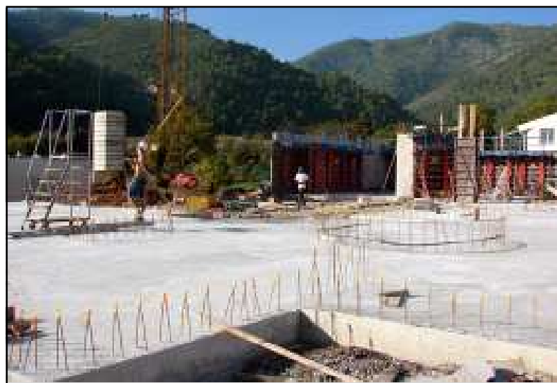
La crèche intercommunale après deux mois de travaux. Livraison espérée en septembre 2007.
