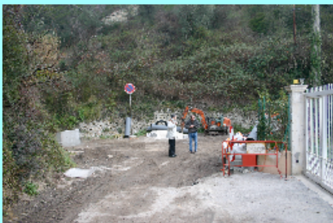
Sur le chemin du Bottin, au point de raccor- dement avec le réseau d'eaux pluviales
