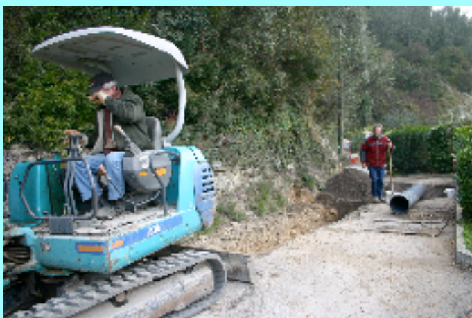
Pose du nouveau réseau d'eaux pluviales sur le chemin
