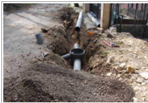
Mise en place des canalisations du réseau d'assainissement.
