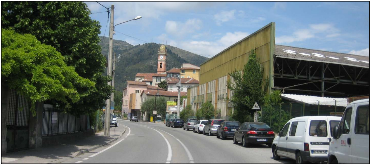
Vue du site depuis le boulevard Général de Gaulle
