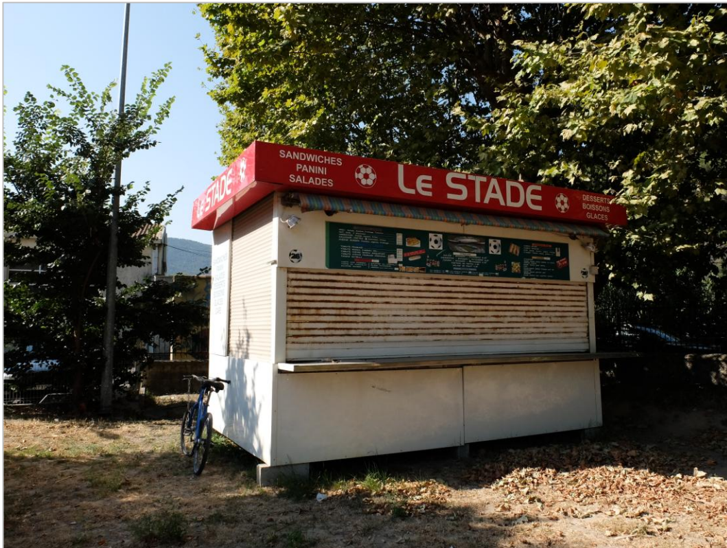
Bâti léger implanté sur le site
