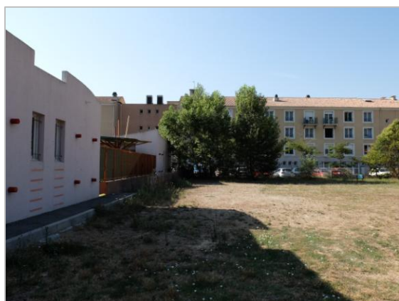
Partie Est de la zone de projet, à gauche, la crèche de la Formiga
