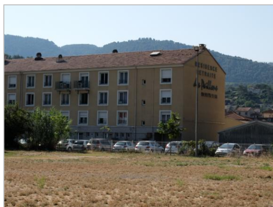
Vue depuis le site du projet en direction du Sud et de la résidence retraite
