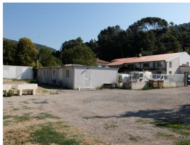
Limite Nord-Est du site et aperçu du garage Renault
