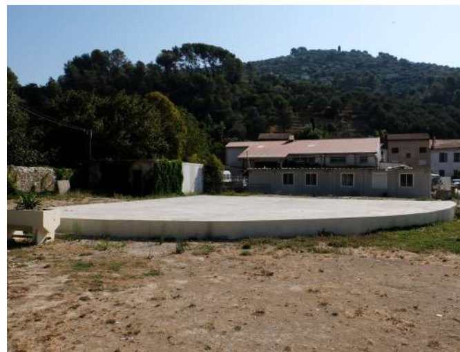
Ancien estrade (partie Nord-Est du site)
