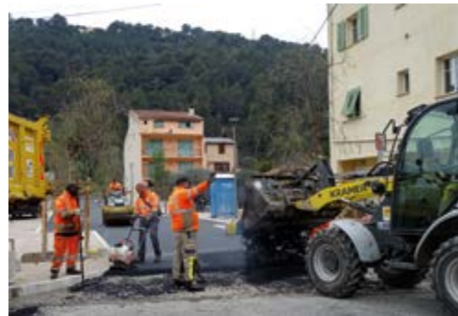
Revêtement perméable pour la Traverse Arnulf
