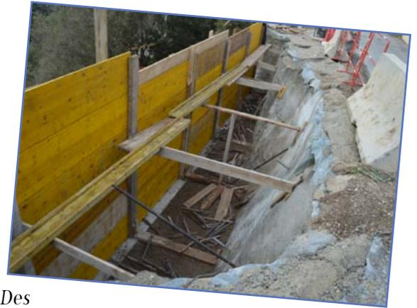
Des barres de fer ont été enfoncées dans le talus à 6 mètres de profondeur. Entre la route et le mur, des ballasts seront installés.
