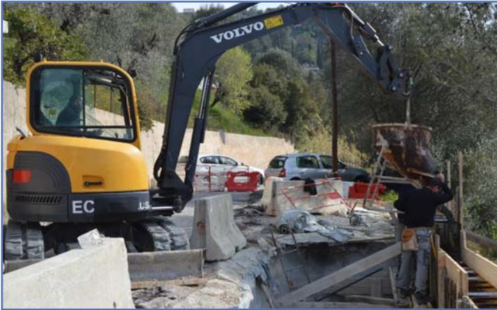
Plus de 5m<sup>3</sup> de ciment ont été nécessaires à la construction de deux murs de soutènement.
