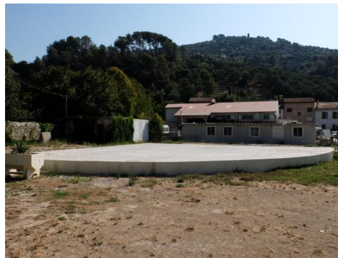
Ancien estrade (partie Nord-Est du site)
