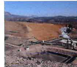
Centre d'enfouissement de Ventavon
