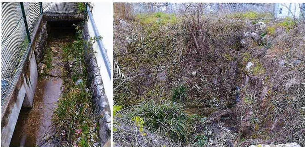
L'exutoire n°2 récupère les eaux issues de la carrière Lafarge. Par temps sec, on observe un écoulement continu d'eaux claires, traduisant la présence d'eaux de nappe. Les eaux sont ensuite collectées dans un caniveau souterrain sous les voies SNCF, dont les dimensions sont les suivantes : H : 0.6 m x L : 1 m. Le rejet s'effectue dans le Paillon.
