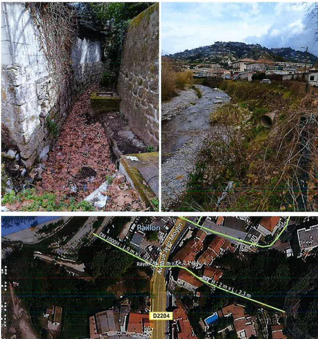
L'exutoire n°10 est constitué en amont un canal à ciel ouvert de dimensions utiles de stockage estimées à : H : 2 m x L : 2.3 m.. Ce canal plonge avec une forte pente sous la départementale. Le passage sous la route présente des dépôts. Une conduite sous pression entrave également le bon écoulement des eaux. Le rejet dans le Paillon s'effectue dans le Paillon par un DN 1000, après passage dans un second canal à ciel ouvert de dimensions utiles H : 1.9 m x L : 2.3 m.
